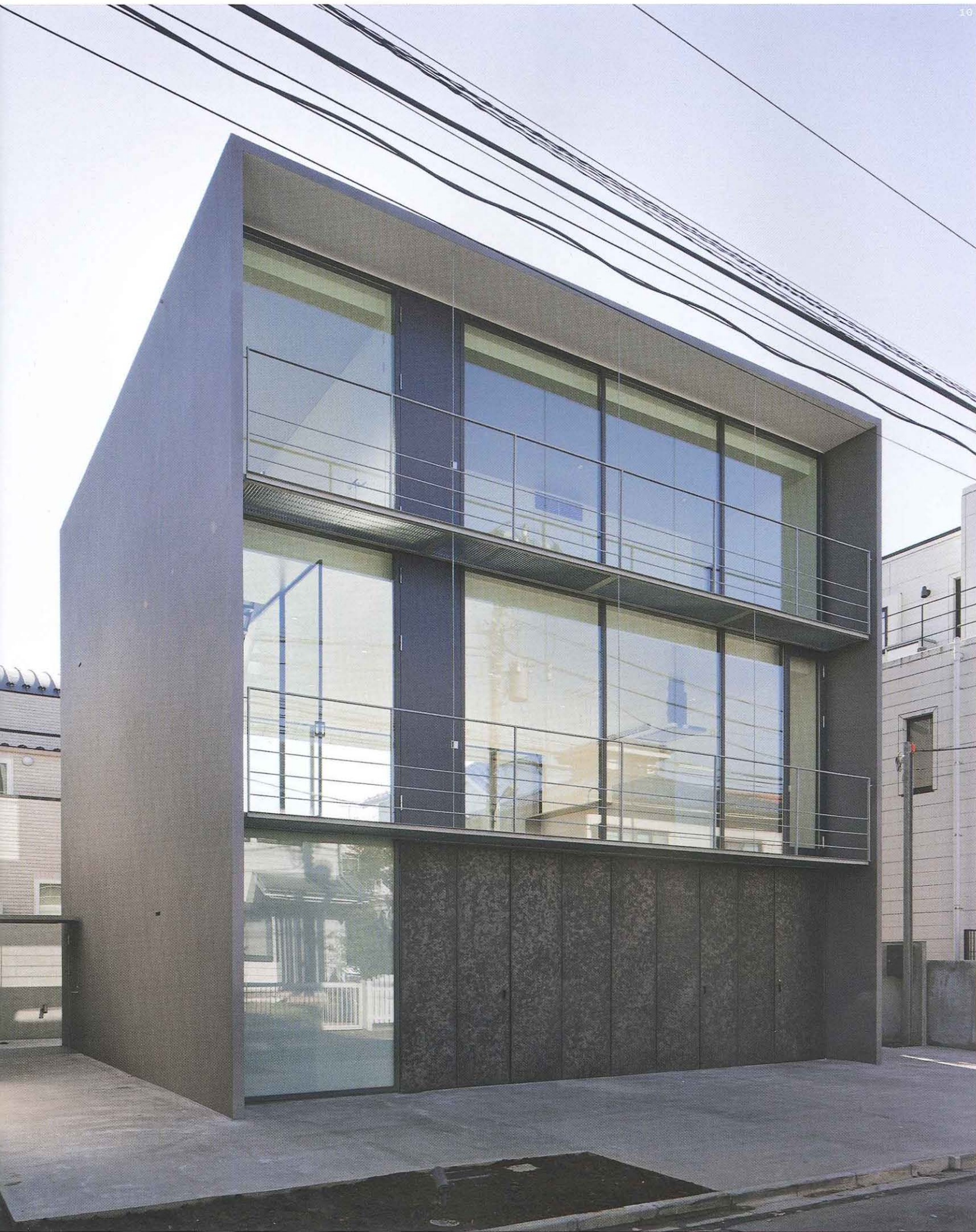
10 -la casa vista da nord-est, in evidenza il sottile involucro portante di 10 cm che racchiude l'edificio -the house seen from the northeast, showing the slender load-bearing wrapper, 10 cm thick, that encloses the building
