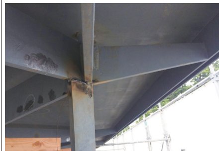
V字柱を菱目梁に溶接
