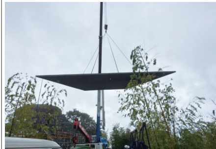
屋根建て方 屋根パネル吊り込み
