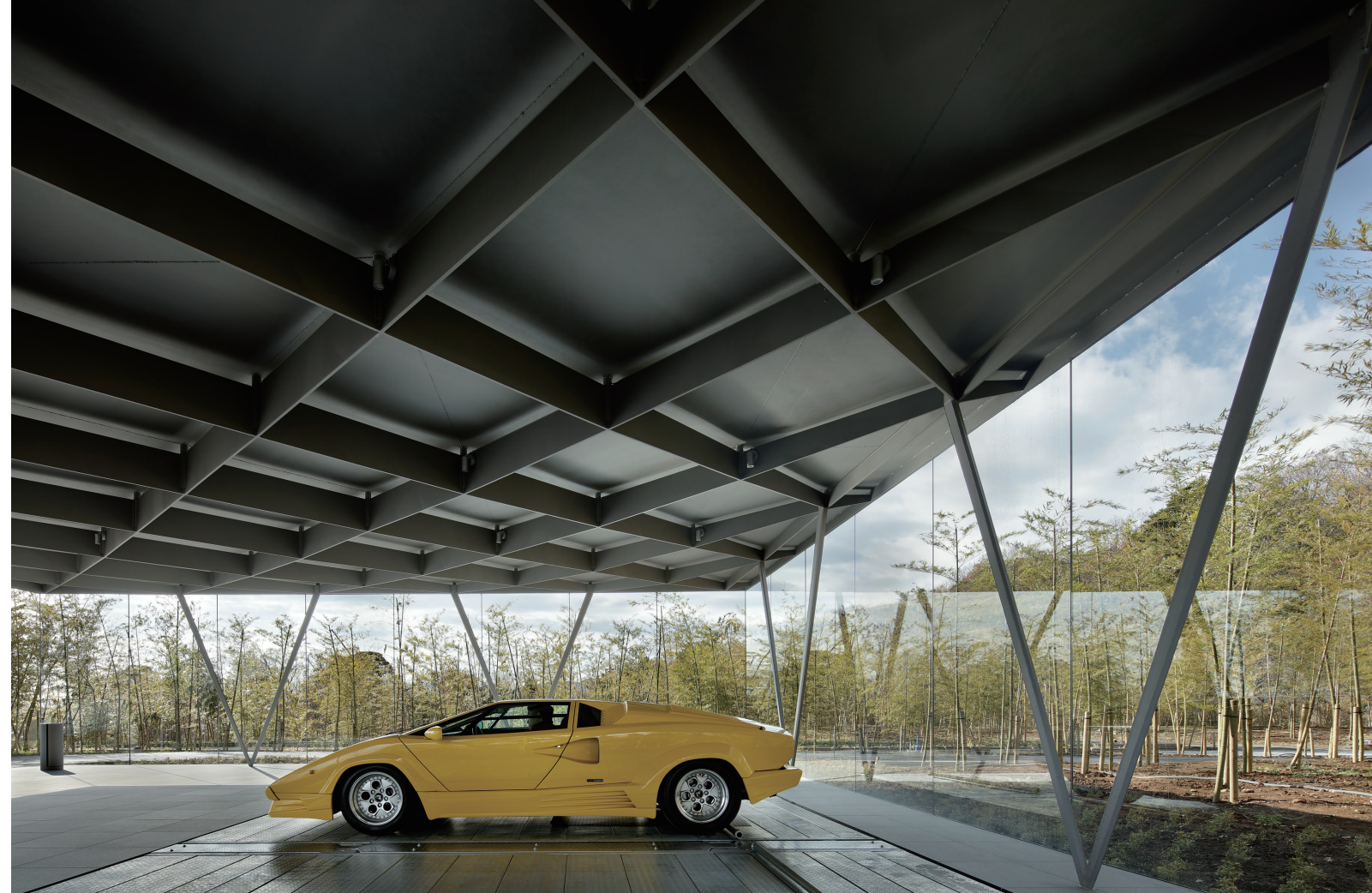
ギャラリー内部から外を見る 平面の1辺にV字柱を2組ずつ配置
