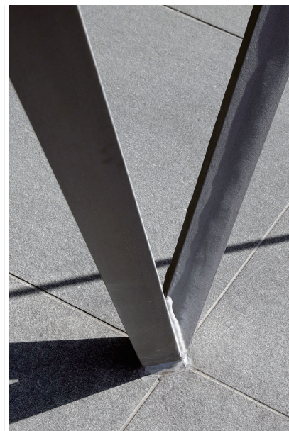
V字柱の脚部
