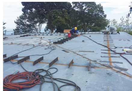
屋根鉄板溶接
