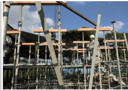
V字柱建て方
