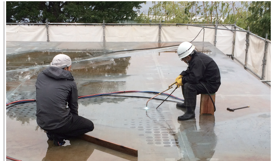
屋根の歪みを、火と水を使った造船撓鉄手法で矯正する
