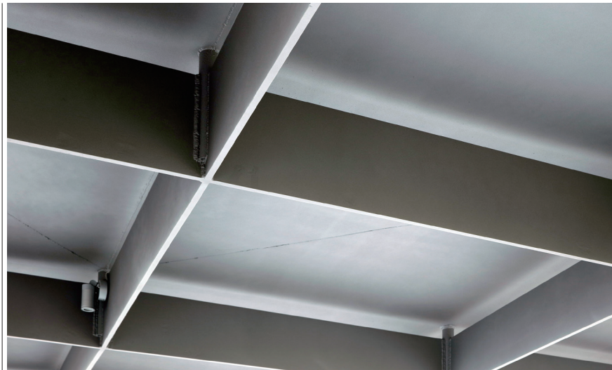
菱目梁は交差部に設けた束柱を介して接合し、その上に鋼板屋根が載る
