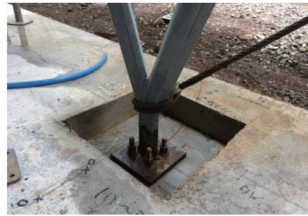
V字柱脚部
