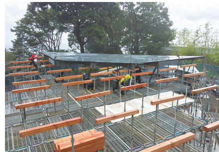
屋根パネルを設置
